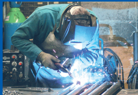
Soudure électrique des fixations
